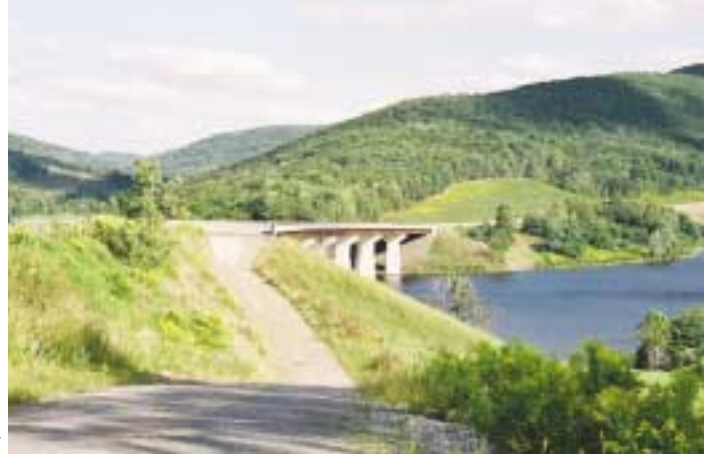
Tioga Bridge, PA, USA
