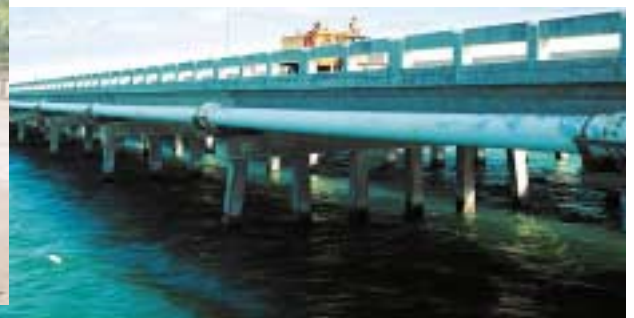
Boca Chica Bridge, FL, USA
